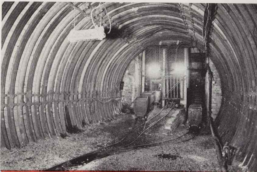
Photo n° 4 : Le point de rebroussement pour wagonnets vides à 942 m.
