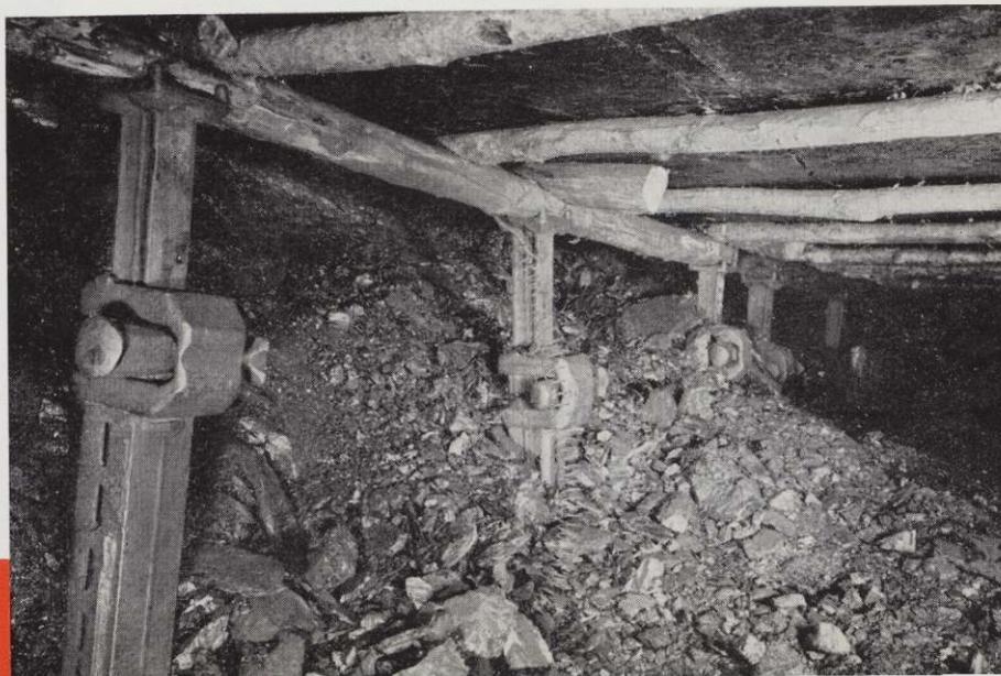
Photo N° 3 Les fronts après minage (Remarquer la canne restant dans les déblais et continuant à débiter de l'eau pour parfaire l'injection).
