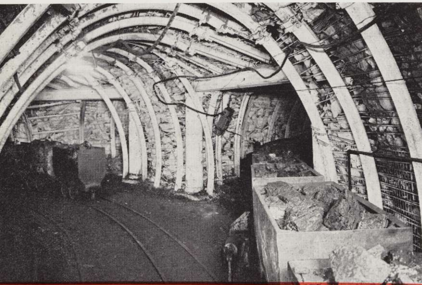
Photo n° 3 : Embranchement des contours pour wagonnets chargés. au niveau de 840 m. (A droite la rame en provenance du niveau de 942 m.)
